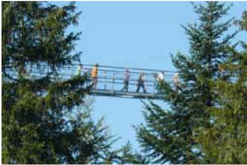
Die Fussgänger-Hängebrücke «Raiffeisen Skywalk»: Diese Brücke überspannt das wildromantische Lautitobel in einer Höhe von bis zu 58 Metern! Die Länge von 374 Meter macht sie zur aktuell längsten Fussgängerhängebrücke von Europa.
