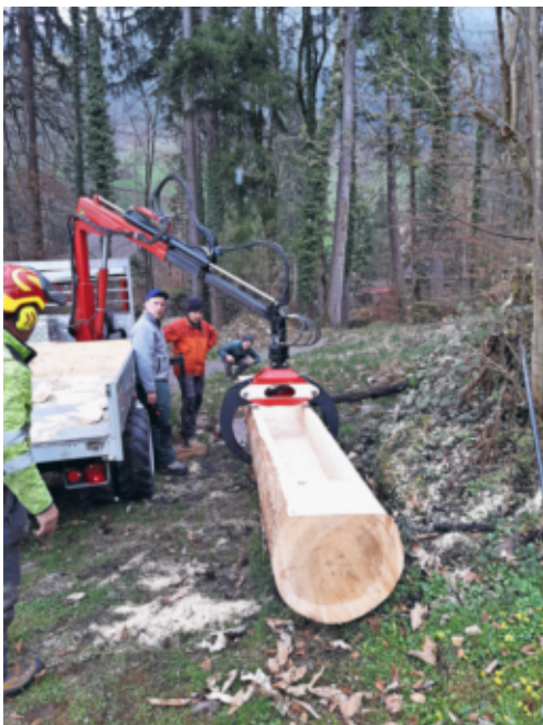
Mit Maschinen- und Manneskraft wurde der neue Brunnen gesetzt.
